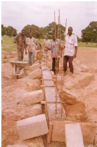
Construction des fondations de la Chapelle de MENE
